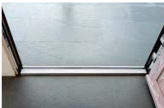
Remate de suelo plano para mantener la estanqueidad al aire
