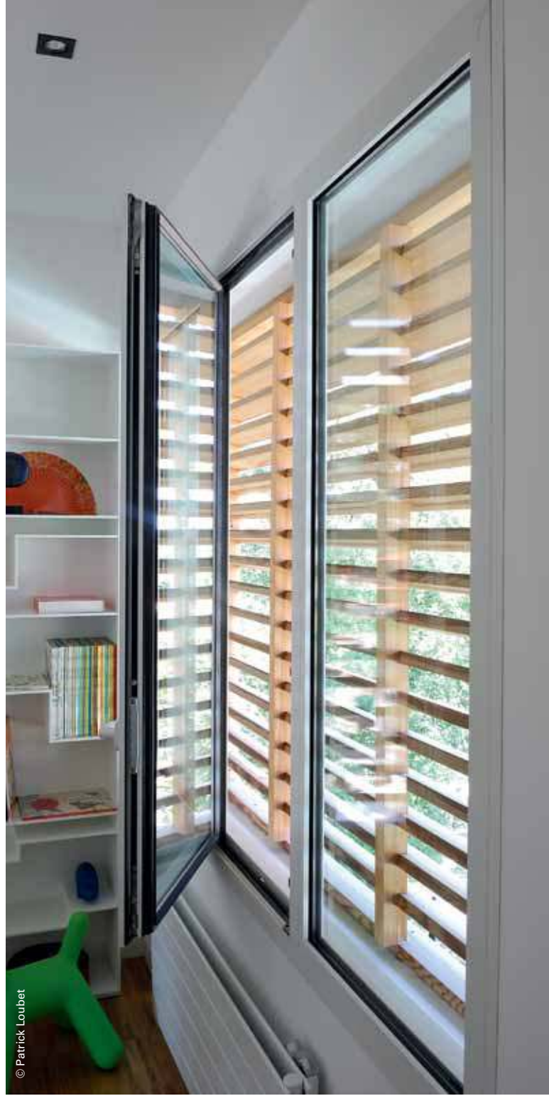
Maniobra de los cierres por cremóna encastrada bidireccional
