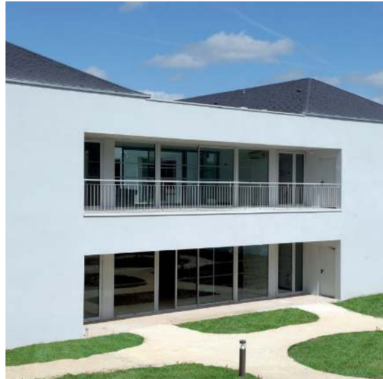
Arquitecto: FONTAINE & MALVY - Fotografía: P. Loubet
